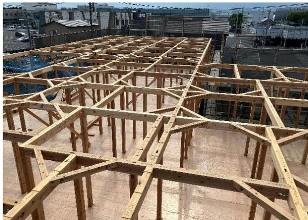
左の写真は建方工事を最上から見たものです。工事従事者以外なかなか立ち会う機会が少ないので貴重な写真です!! 最近ではプレカット技術の向上により、大型の木造建築で多くなってきました。建方大工により1本1本しっかり組み立てています。
