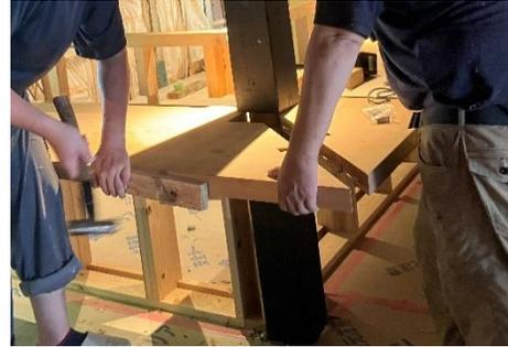
切欠きを行い、板を柱にはめ込む形で納めました。職人がミリ単位で切欠きの調整を行い、分割されていた板が、ぴったり突き付けられ、とても綺麗な一枚板のテーブル・カウンターが仕上がりました。
